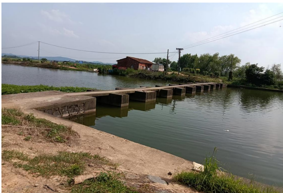
图2-1 云溪区白泥湖田山闸照片
