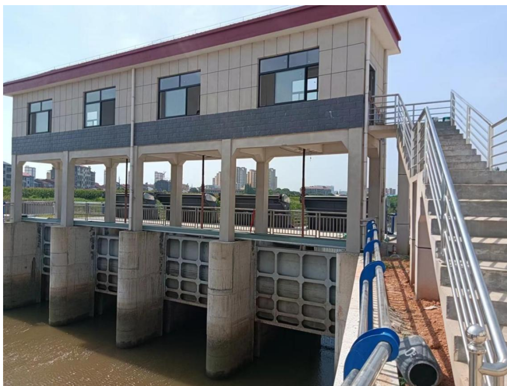
图2-7 云溪区象骨港节制闸照片
