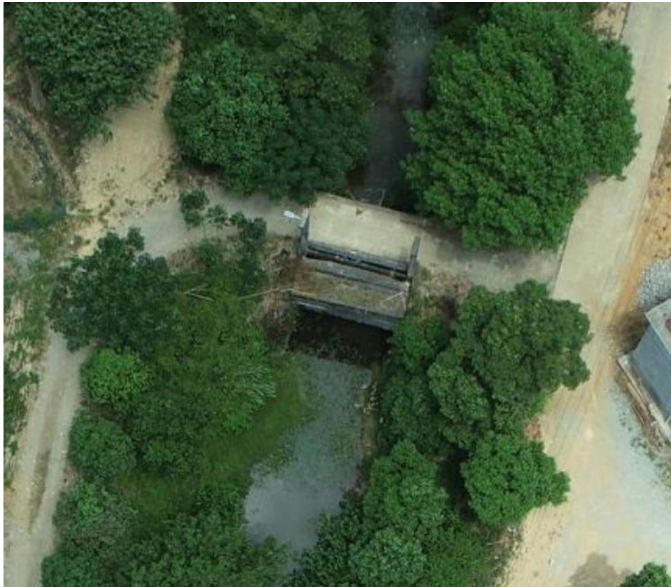
图2-9 云溪区范家咀闸照片
