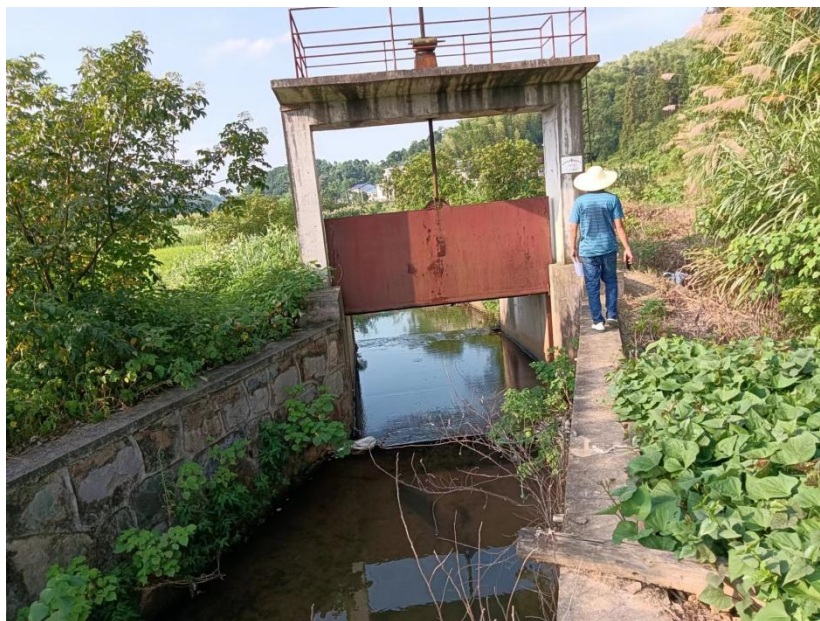
图2-15 云溪区林木冲节制闸照片
