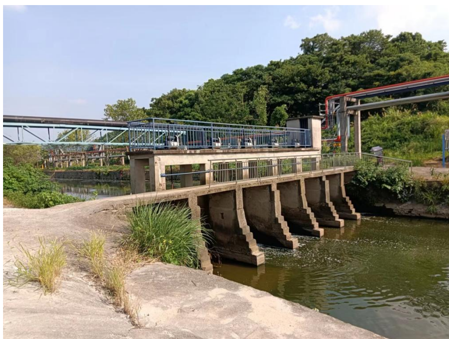
图2-3 云溪区林家堰灌溉闸照片
