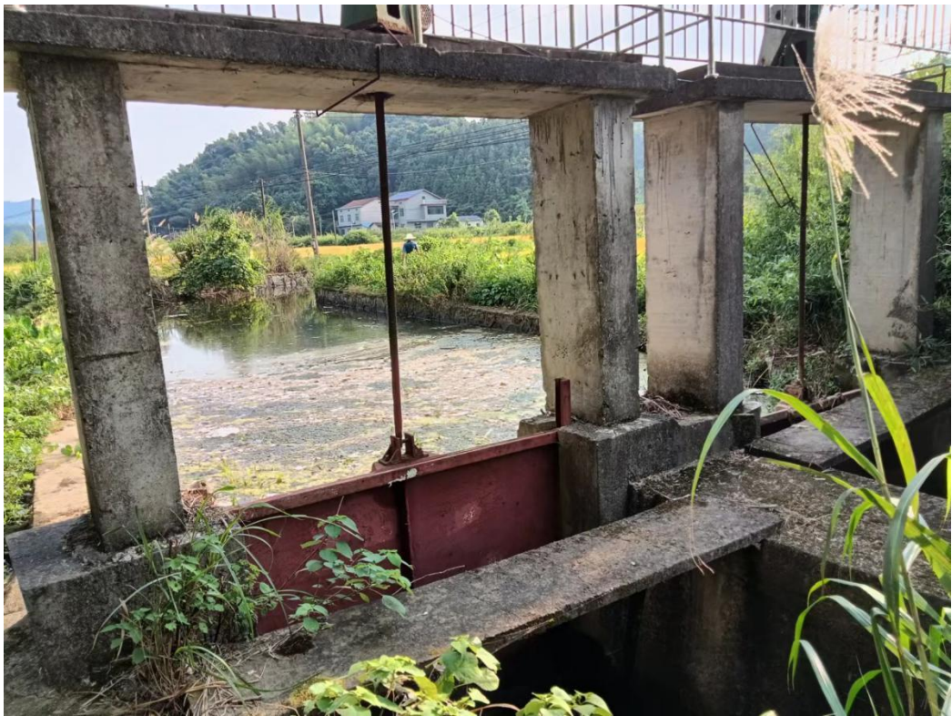
图2-11 云溪区抬头畈节制闸照片
