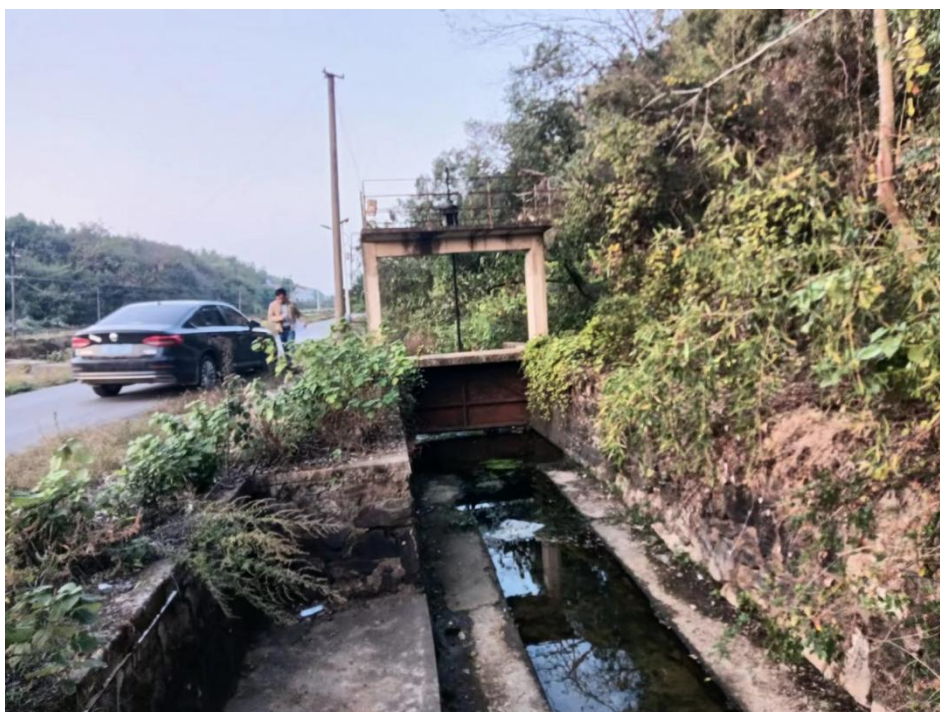
图2-19 云溪区青岗水库泄洪渠节制闸照片
