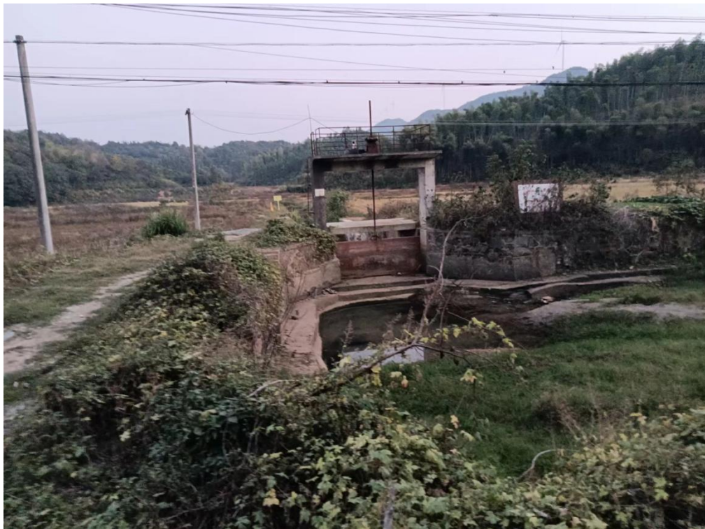
图2-17 云溪区汾水堰节制闸照片
