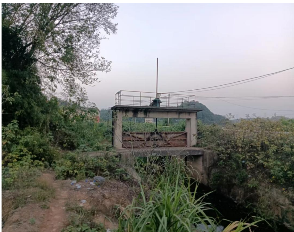
图2-13 云溪区主泄洪渠节制闸照片
