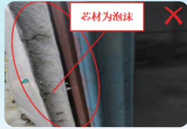
临时工程宿舍、办公用房采用泡沫彩钢板搭建
