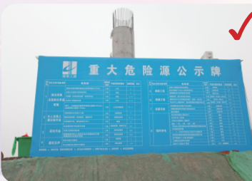
应对项目的重大危险源进行挂牌公示
