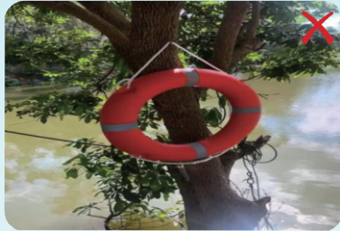
水文监测站救生设备、堵漏器材等安全防护设备未配备齐全完好，放置位置不符合要求
