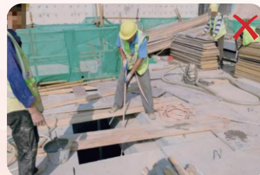
建筑(构)物洞口、临边、交叉作业无防护或防护体刚度、强度不符合要求
