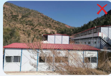
施工驻地设置在滑坡、泥石流、潮水、洪水、雪崩等危险区域
